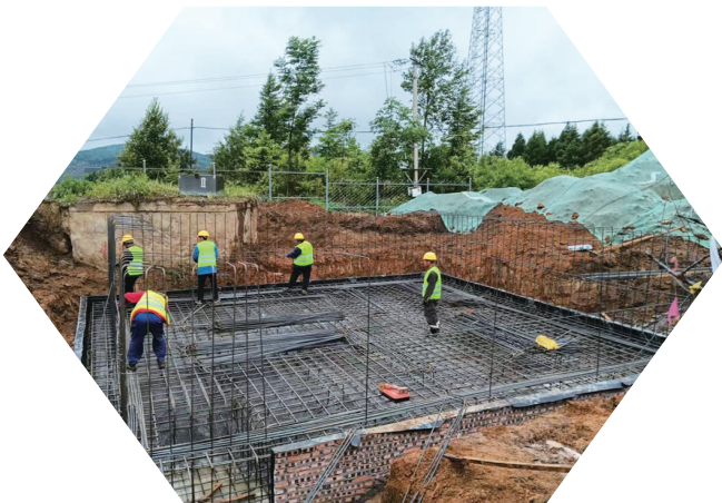
近日,抚松县万良镇高升村自来水改造及部分基础设施提升项目开工建设,为群众日常生活筑牢用水保障。
