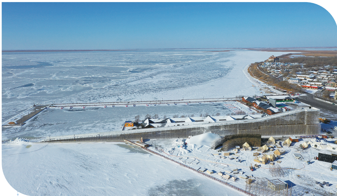
松原市创新打造全国首个沉浸式探秘冬捕文化主题园区——查干湖龙鱼部落度假区,园区占地40万平方米,包括探秘龙鱼市集、腾鱼雪洞奇缘、千年渔猎祈福、冬捕体验和冰上综合比赛互动5个区域,目前正在紧张施工中。 记者 郭小宇/摄
