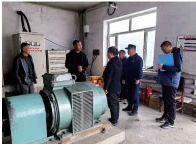
松树镇特种设备领域安全专项整治工作专班对煤矿绞车房进行安全隐患排查
