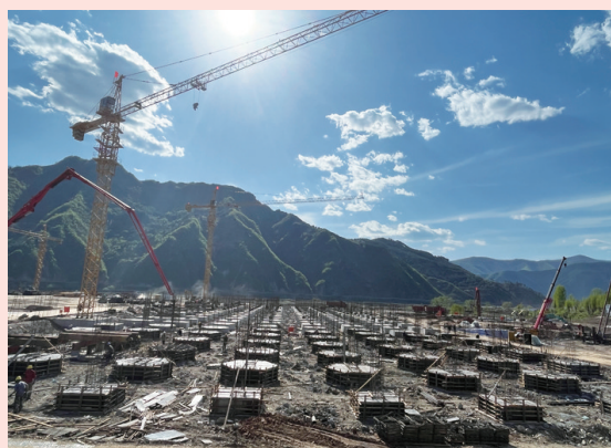
临江市通过“向上争、平台融、社会引”等举措,扩大就业、交通、能源、生态、文化旅游、城乡建设等有效投资。全年计划实施5000万元以上项目30个,总投资89.13亿元,预计完成投资33.23亿元。图为鸭绿江河谷生态食药产业园项目施工现场。
