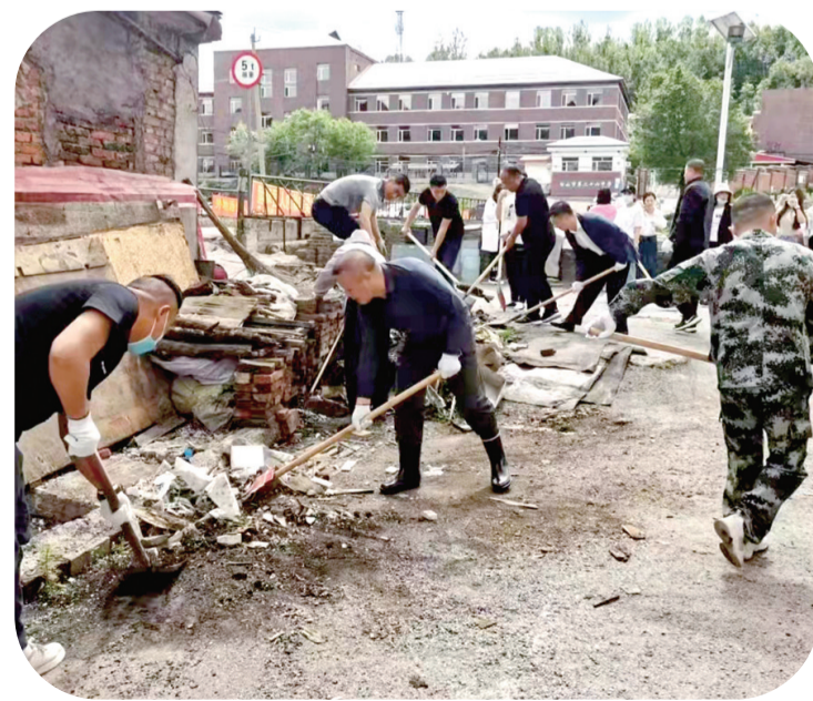
下沉机关干部深入村屯开展环境卫生整治
