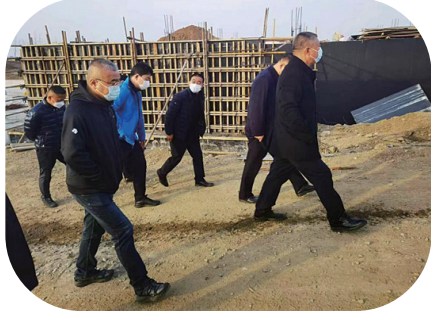
近日,吉林市船营区相关领导到大绥河灌区橡胶坝工程现场检查,要求在保证质量的前提下,加快施工进度,务必在明年春耕期间投入使用。
