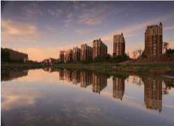
工程和6个生态修复区建设。目前，小南河综合治理工程已完成95%以上，预计年末竣工。 (朱海涛)
