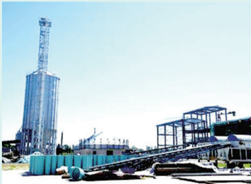
十月稻田松原农业科技产业园项目,是十月稻田集团投资2亿元在松原全力打造的重点稻米加工项目。该项目全部建成投产后,年大米加工能力可达50万吨,年产值预计可实现20亿元,带动就业300人。图为施工现场。
