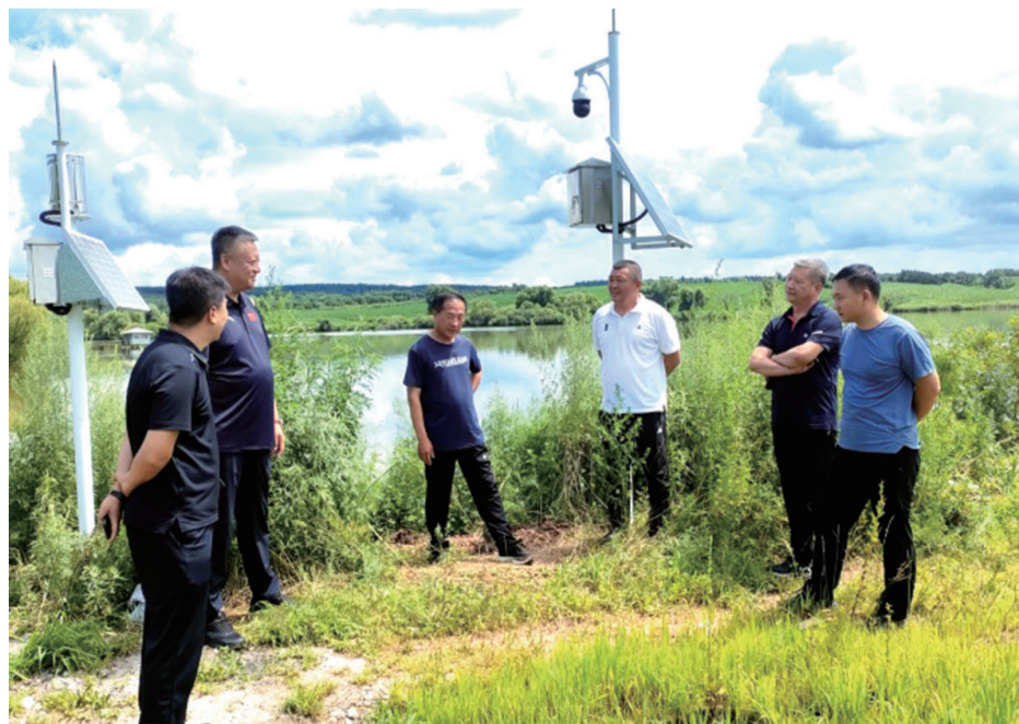
公主岭市东方红水库除险加固项目现场
