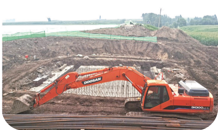
长岭县黑泉眼水库除险加固项目现场
