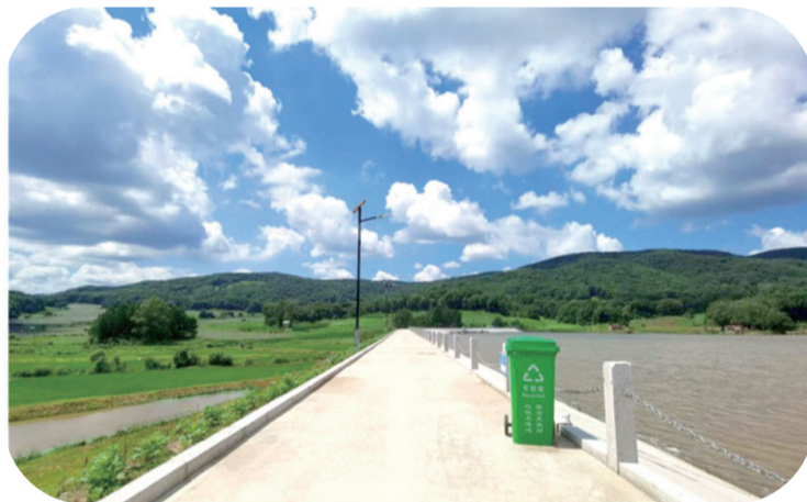
磐石市永丰水库标准化管理现场
