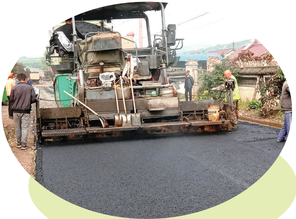
正在建设的乡村柏油路
