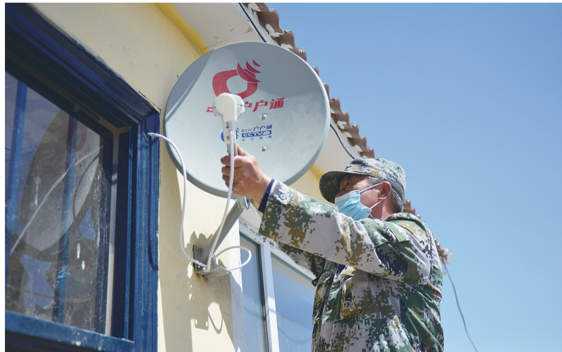
通榆县加快建设乡村信息基础设施,加快农村宽带通信网、移动互联网、数字电视网发展。图为通榆县农村广播电视有限责任公司为向海乡创业村农民安装网络电视。
