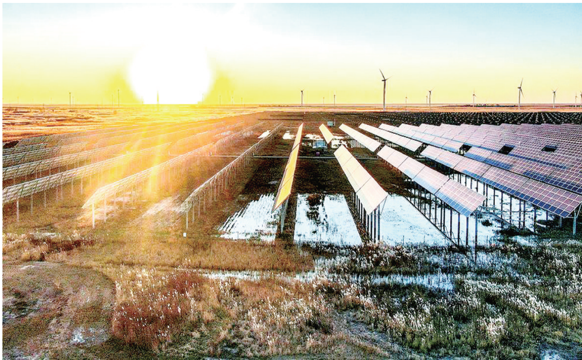
白城市按照“一主六双”高质量发展战略部署,全力推进“陆上风光三峡”工程建设,着力打造国家级清洁能源生产基地,加快实现新能源装备本地化、产业集群化。图为白城光伏发电应用领跑基地镇赉项目区一角。
