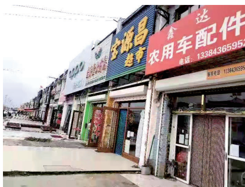
拆除临街违建“封闭式”
