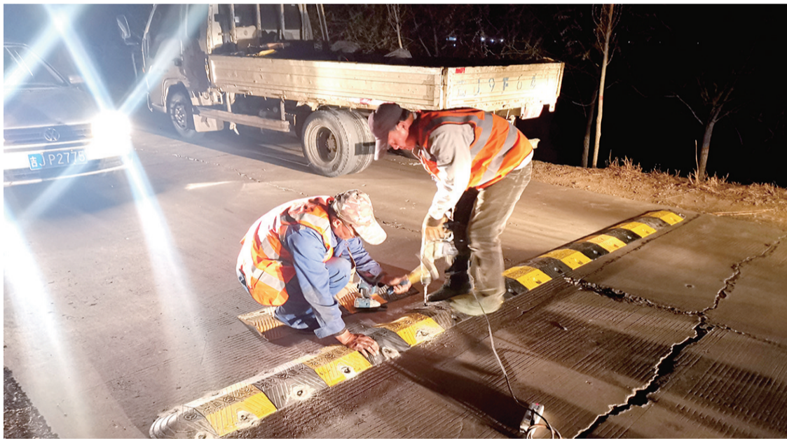
今年以来,乾安县加大农村道路交通安全整治力度,采取有力措施,确保道路安全畅通。图为在让字镇小成村路口安装减速带。王殿海/摄
