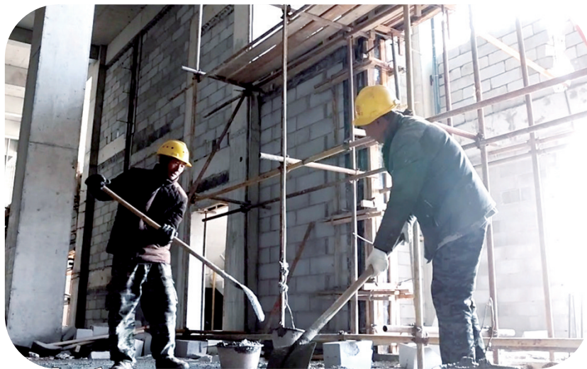
正在紧张施工的建筑工人
