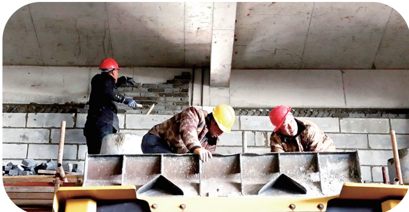
内部装修阶段快速、有序推进
