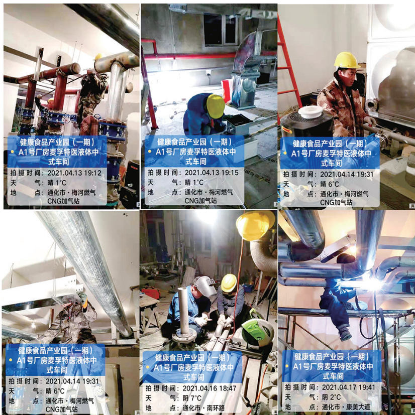
施工场景集锦
