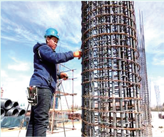
目前,查干湖生态小镇“两馆”项目建设如期推进,现场劳动场面火热。“两馆”即渔猎博物馆、生态文明展示馆,位于生态小镇规划10、11区块。工地上,100多名工人和数十台机车正在紧张施工。 韩冰/摄
