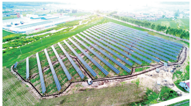
覆盖各村的光伏扶贫产业项目
