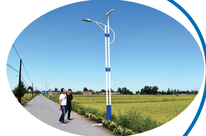
巡查维护新安装的路灯
