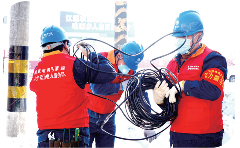
江源供电公司共产党员服务队队员为江源区G11鹤大高速公路白山东出口公安检查站发热检车点安装临时电源
