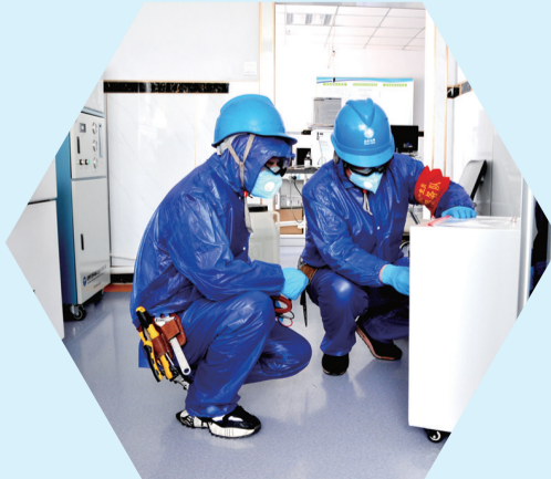
疫情期间,江源供电公司共产党员服务队建立“7×24”全天候供电保障专属服务队,为江源区定点发热门诊和隔离区检查检验科、放射线科用电设备。
