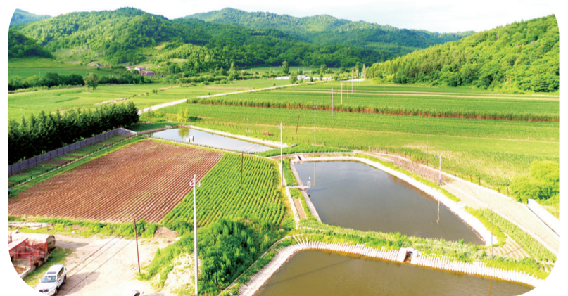
10千伏湾沟三线改造后线路状况
