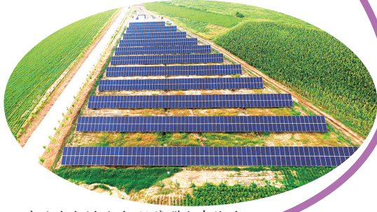
光伏发电增效益,保障群众有收益
