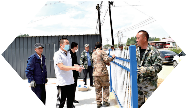
丰收村正在安装铁艺栅栏
