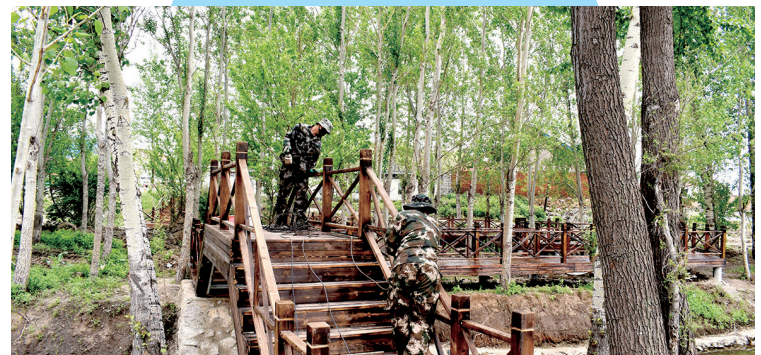
宝山村正在进行景点建设
