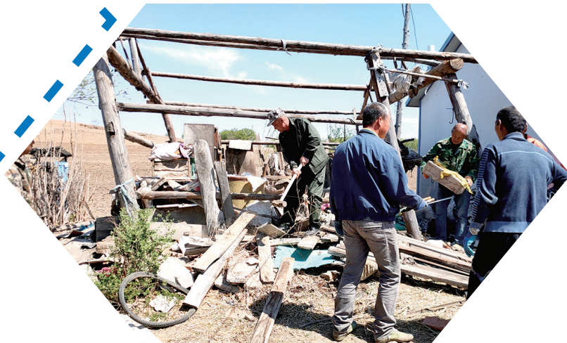
拆除有碍观瞻的棚厦
