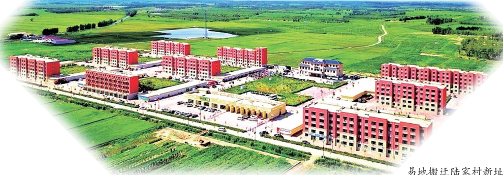
易地搬迁陆家村新址
