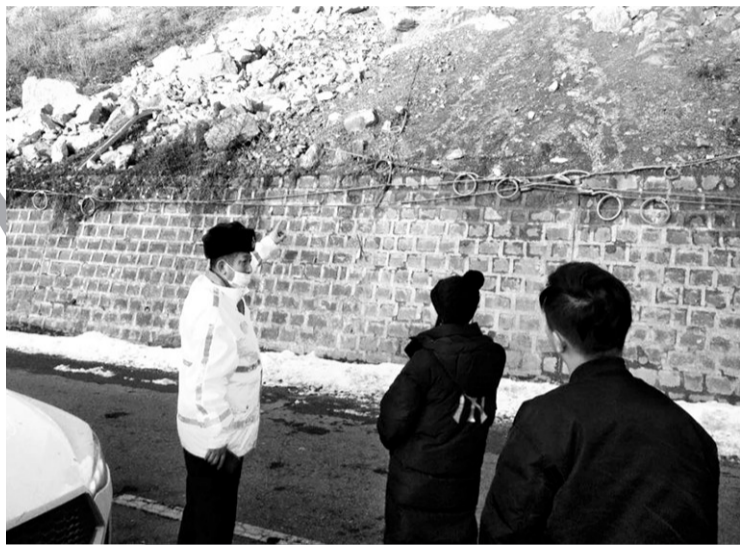
为保障道路安全畅通,长白县公安局深入辖区道路全面开展隐患排查。排查中,长白县交警采取沿线巡逻、实地勘查等措施,对辖区道路进行严密细致的排查。全面排查道路临水临崖、易滑坡、陡坡、连续下坡、视距不良、弯急、事故多发的点段,有无设立安全防护设施和交通标志、标线,并对自然灾害等原因造成公路损毁等隐患进行了排查登记。
